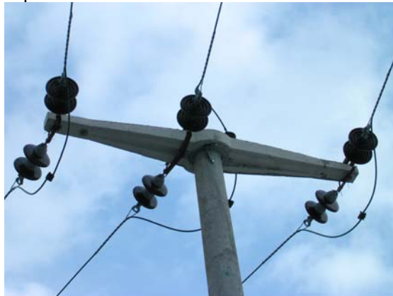
slika 9. Vrh ugaono - zateznog stuba na 10 kV vodu »KRAVLJI DO – ŠLJIVOVAC«
