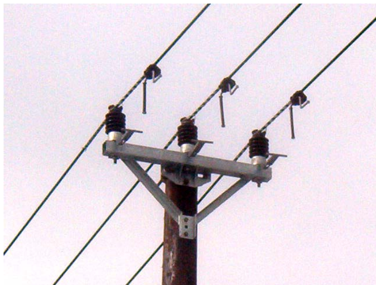
slika 5. Vezivanje izolovanog užeta za potporne izolatore (nadzemni vod 24 kV, vrh nosećeg stuba)
