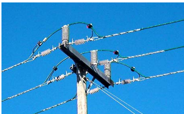
slika 6. Zatezanje izolovanog užeta zateznim izolatorima (nadzemni vod 24 kV, vrh ugaono - zateznog stuba)
