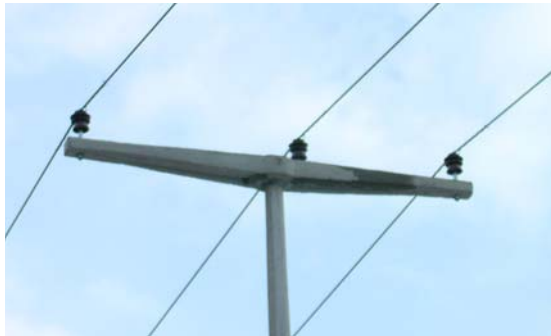
slika 8. Vrh nosećeg stuba na 10 kV vodu »KRAVLJI DO – ŠLJIVOVAC«
